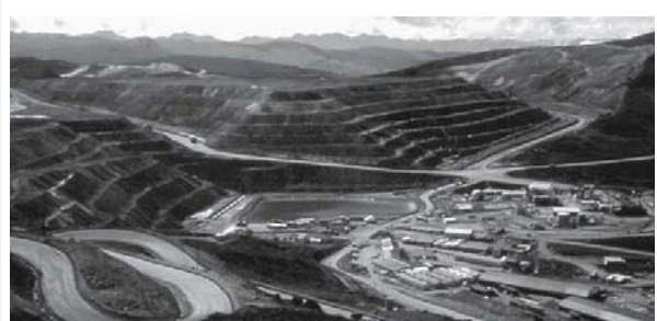
Kyanizace haldového materiálu ve velkém měřítku, zlatodůl Yanacocha, Peru
