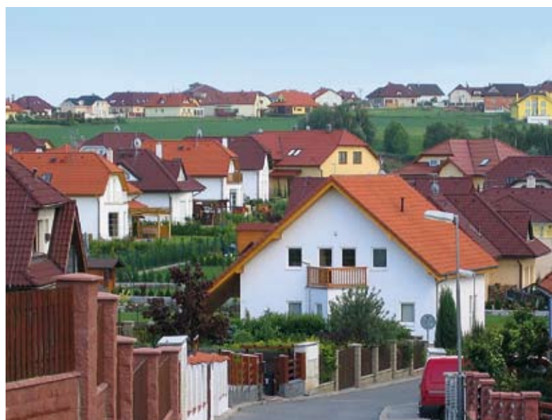
Dole: Nic než nové rodinné domky: „sprawl“ na jihovýchodě Prahy – nová Hlubočinka, obec Sulice. Snímky na této straně © Luděk Sýkora.
