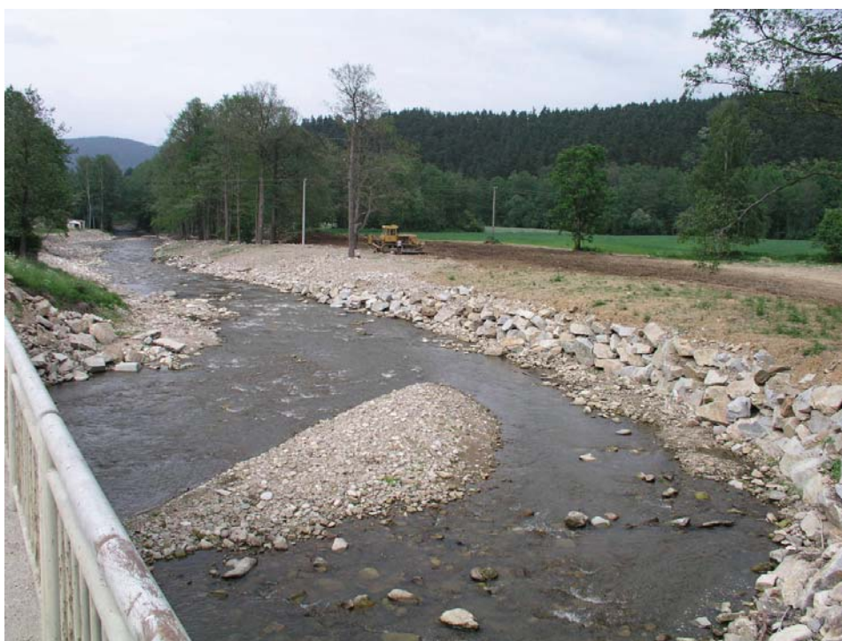
Obrázek 8: Upravené koryto i přilehlá část údolní nivy za bohumilickým mostem. Během povodně bylo koryto přesunuto a Volyňka pokračovala přímo. S tím souvisel vznik povodňových akumulací „hluboko“ v údolní nivě ve velké vzdálenosti od předchozího i stávajícího antropogenně určeného koryta. Foto: M. Křížek, 2003.
