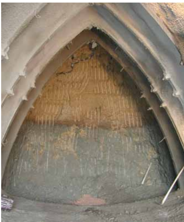
Obr. 2 (a) Průzkumné štoly situované v kalotách tunelů Královo Pole, (b) detail štoly s rozhraním zdravého a zvětraleho terciérního jílu /10/. Fig. 2 (a) Exploratory drifts situated in the top headings of the Královo Pole tunnels, (b) detail of the drift with the boundary between weathered and healthy tertiary clay/10/.
