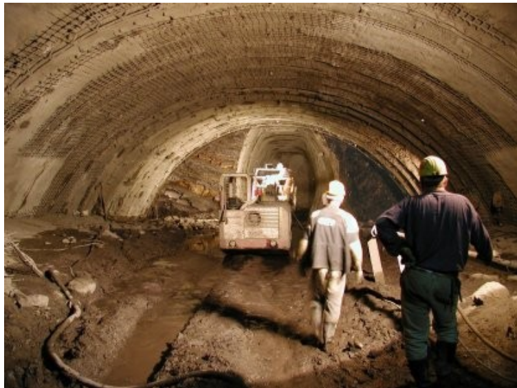
Obrázek 1: Průzkumná štola a výhybna č. 8. ve staničení 12,906 km.
