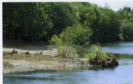
Überschüttete Totholz-Baumbuhne in Kombination mit ausschlagsfähigen Weidenwurzelstöcken.
